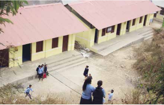
Janak Secondary School sijaitsee Gimdin vuoristoalueella Nepalin keskiosassa. Kirkon Ulkomaanapu rakensi koululle kaksi luokkarakennusta. Kuva: Kirkon Ulkomaanapu
